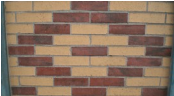
Briques en panneresses au marché couvert de Saint-Mihiel
