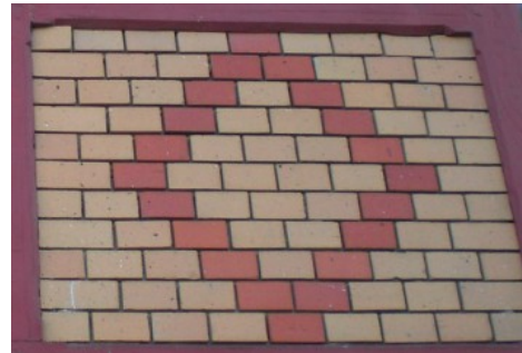
Briques en boutisses au château de Remelfing
